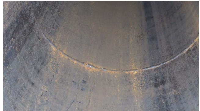
300 A配管内部溶接部撮影画像
